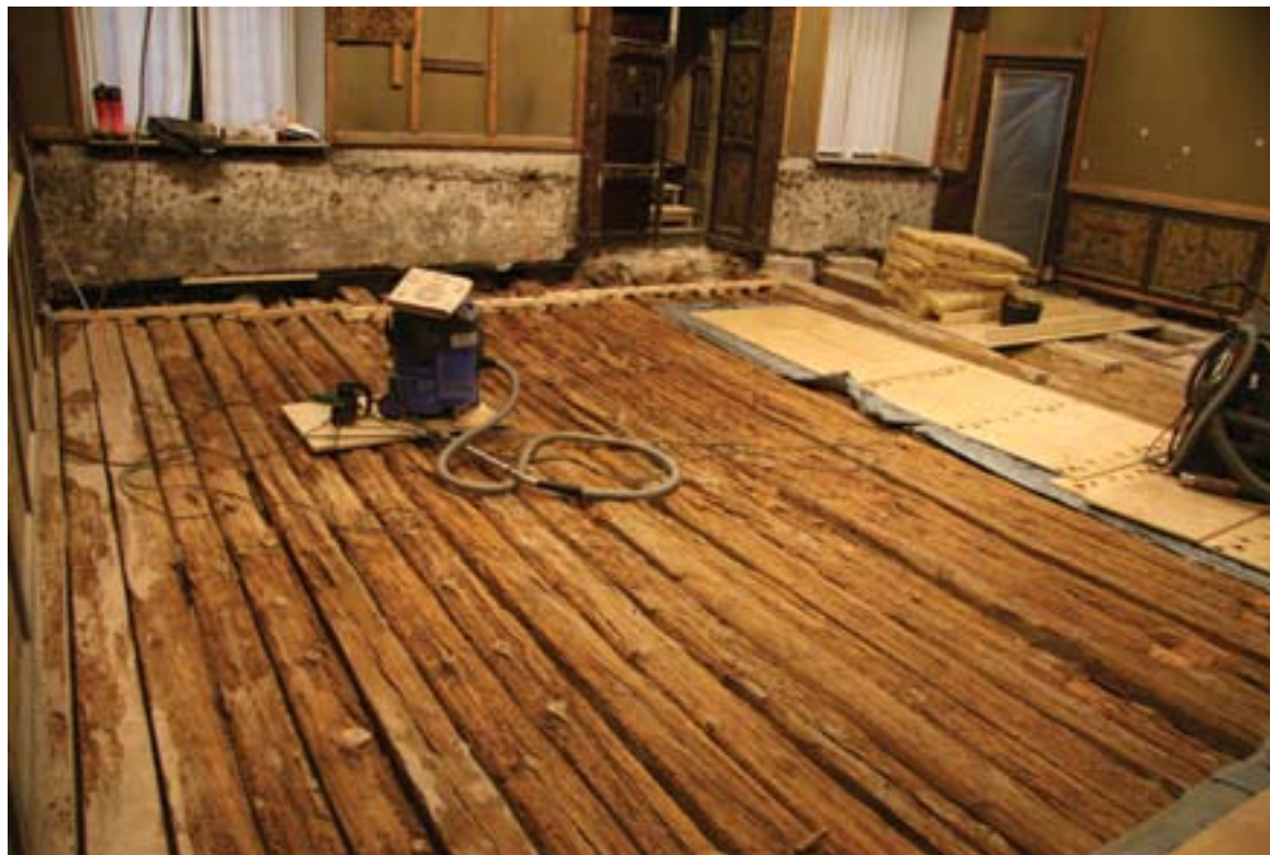
"Rosen" på slottets første sal under renovering.
