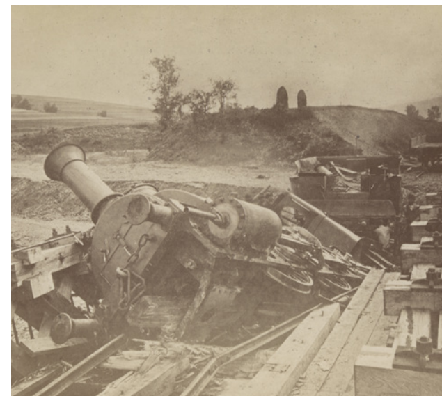
Afsporingen af persontoget ved Jablunkov (nuværende Tjekkiet) 18. august 1872, efter at skinnerne var undermineret af højvande. Fra albummet "Eisenbahn-Unfälle. In Oesterreich 1861-1872", oprindeligt i Christian 9.s eje.
