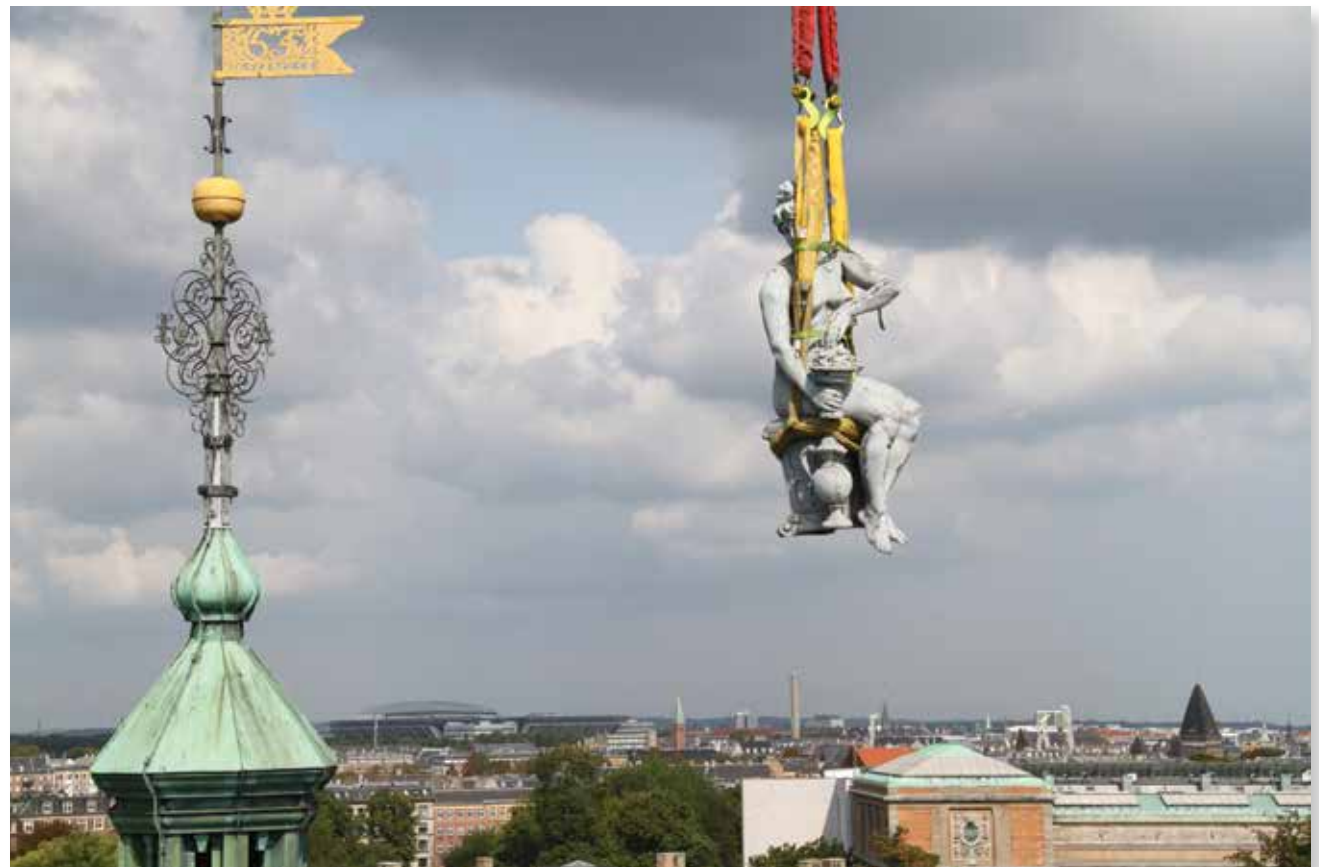
I 2013 fuldførtes etape 6 af Rosenborgs facaderenovering, der omfattede det store tårns murværk. Tårnets zinkfigurer blev under stor mediebevågenhed hejst ned på en blokvogn og kørt til restaurering hos Nationalmuseet i Brede.
